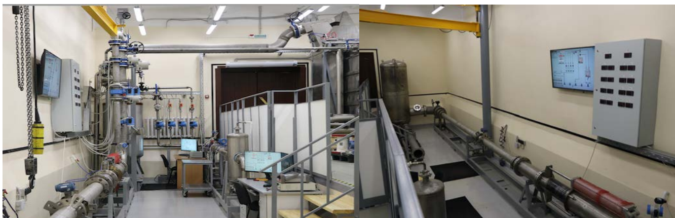
Поверочная установка РУОМ
